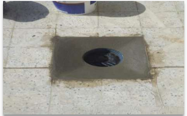
تم عمل تصريف تحت البلاط لسحب المياه الي بلاعة تصريف المياه
