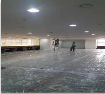
أعمال دهان ومعالجة آثار الأمطار بمصلى النساء
