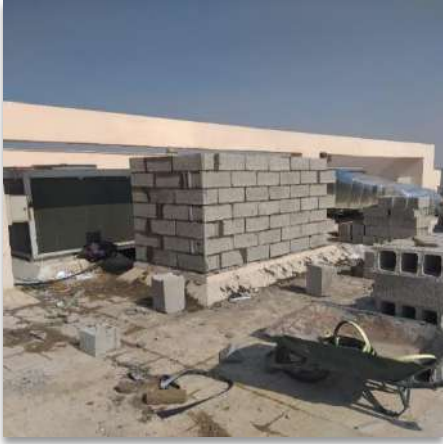
بناء مدخل الدكت
