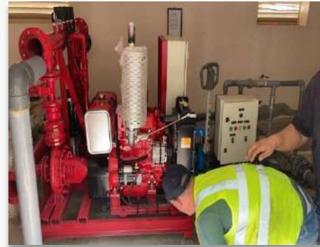
إحلال وتجديد مضخة الحريق
