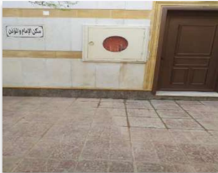
إعادة تأهيل نظام الحريق
