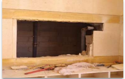
أعمال إحلال وتجديد لأجهزة التكييف
