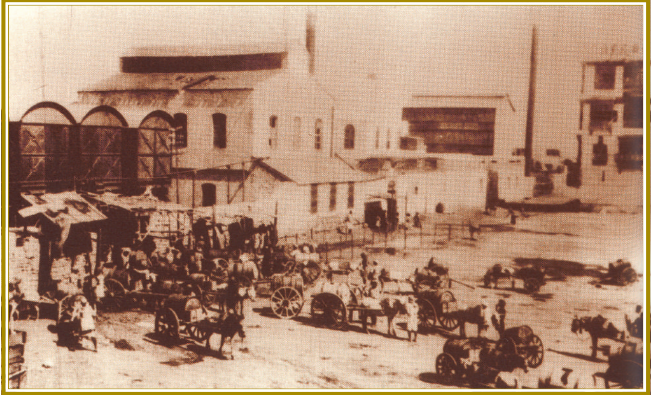
محطة تحلية بواسطة التقطير لمياه البحر (الكنداسة)
